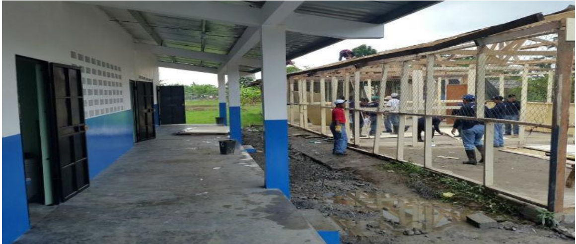
Fuente: Panamá América. Construyen cuatro salones en escuela de Teobroma en Bocas del Toro
