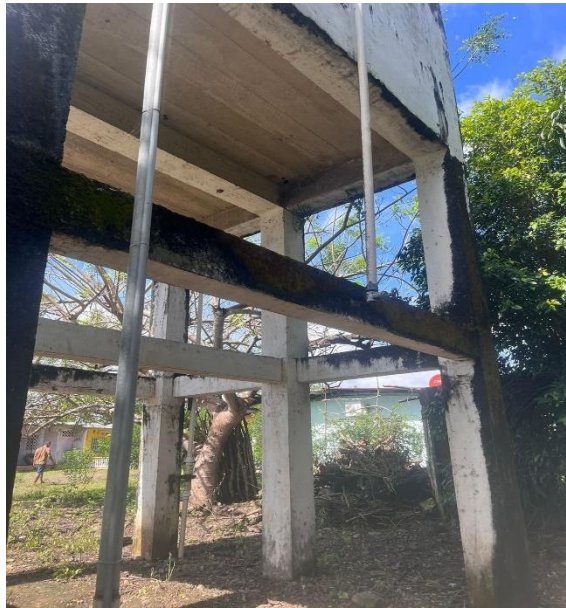
FIGURA N°31: Parte externa del tanque de reserva donde se toman las muestras para determinar la calidad del agua potable.
