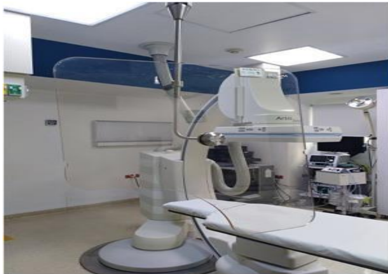
Figura 16. Mamparas plomadas suspendidas del techo.
