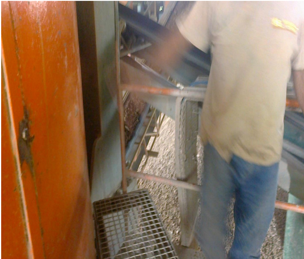
Fotografía N°8: Colocación de barandal en horno túnel.
