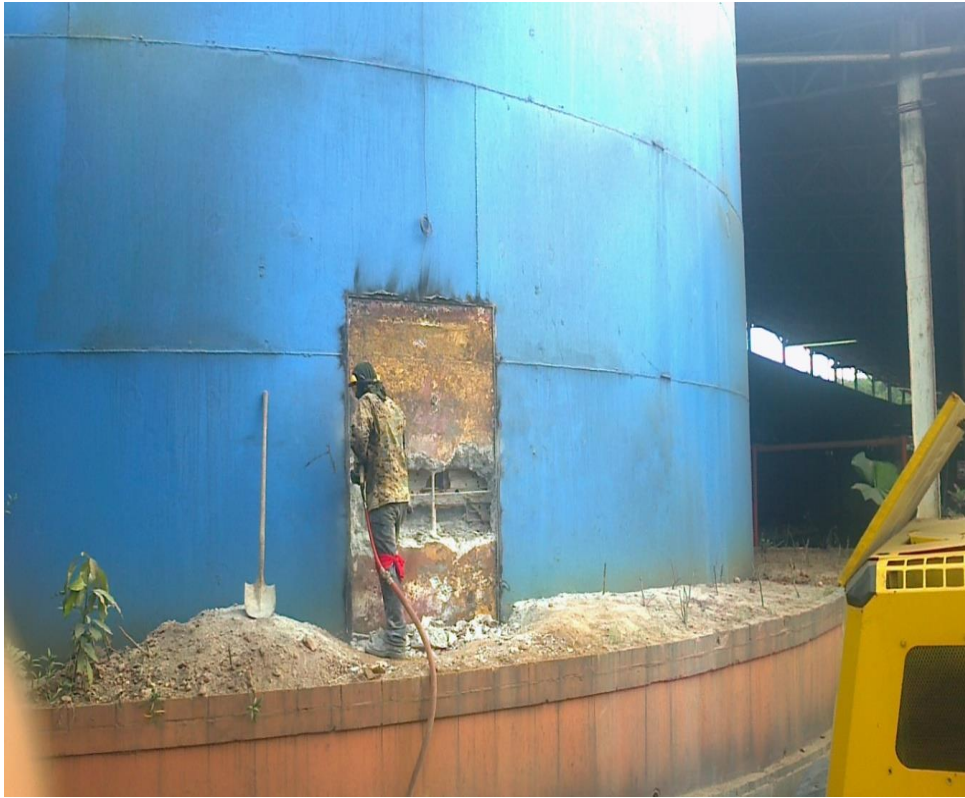
Fotografía N°7: Reparación de la chimenea del horno túnel.
