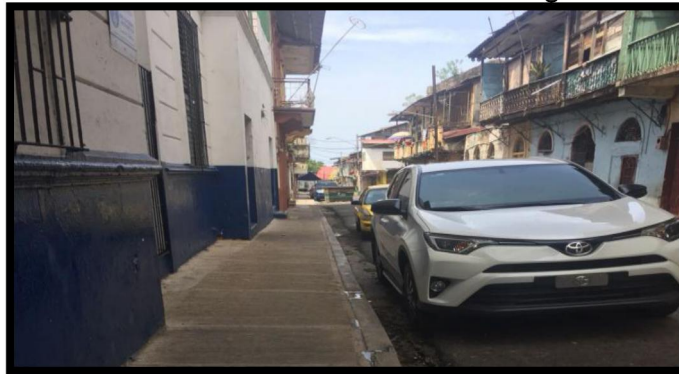
Figura N°5. Vista lateral derecha de la Escuela Bilingüe Manuel José Hurtado
