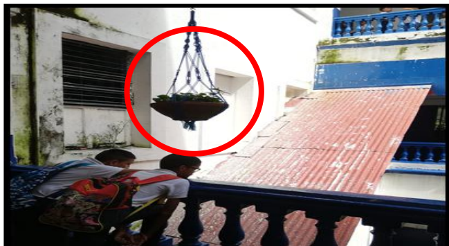
Figura N° 5. Maceteros mal colocados
