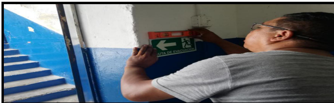
Figura N°36. Colocación de las señalizaciones con las medidas adecuadas
