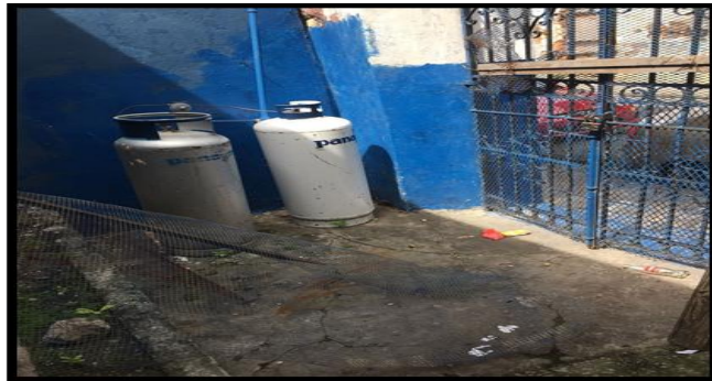
Figura N° 2. Tanques de gas a la intemperie y en salida
