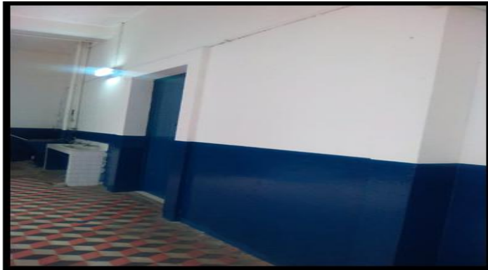
Figura N° 14. No extintores ni botiquines
